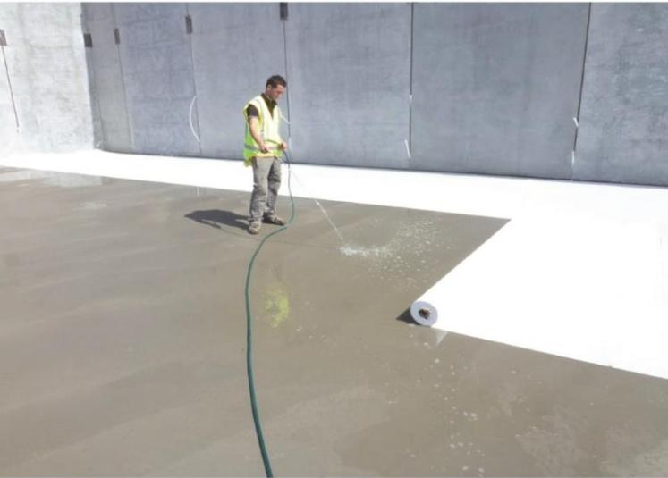
یک مایع عمل آوری بتن که برای جلوگیری از تبخیر آب بتن استفاده می شود
