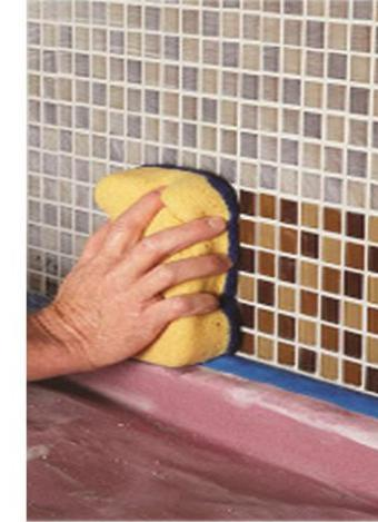
پودر بندکشی يك جزئي پايه سيماني اصلاح شده با پليمر و مقاوم در برابر آب و مناسب استفاده در تمامي شرایط آب و هواي و در رنگ هاي متفاوت قابل عرضه است
