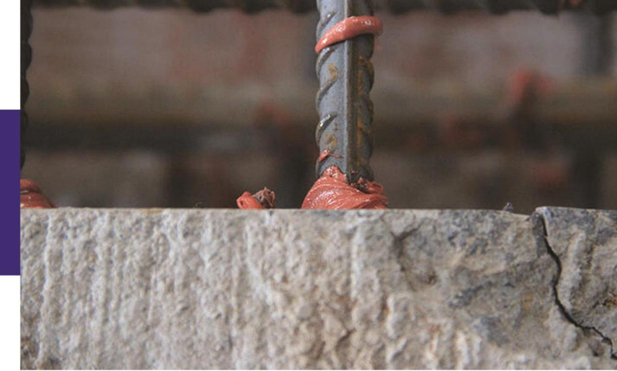
چسب کاشت میلگرد در سطوح عمودی و افقی قابل استفاده می باشد. چسب کاشت میلگرد یک محصول سه جزئی است که بر پایه اپوکسی اکریلات است و این فرآورده باعث می شود که میان بافت قدیمی بتن و بافت جدید آن یک رابط قوی و پر استحکام به وجود بیاید
